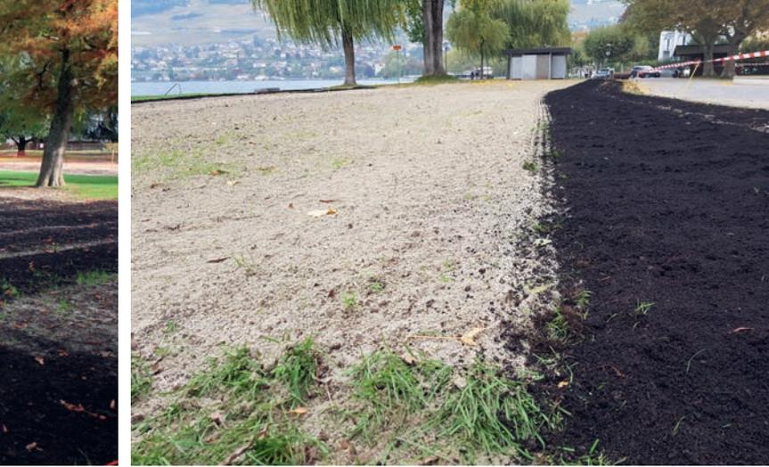
**Auf das Fräsen des Bodens folgte das mechanische Ausbringen von Sand und Humus.** Foto: Swiss Green SA
